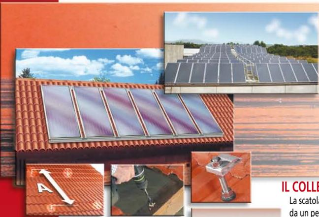
La quota A si riferisce al posizionamento di collettori verticali (mm 202) oppure orizzontali (mm 102)
